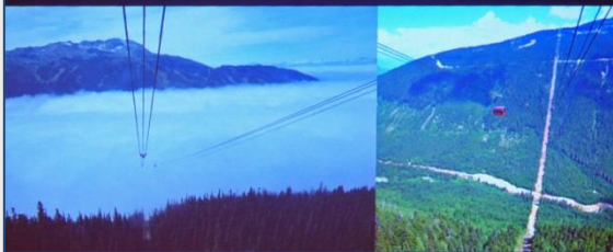
全長4400mが支柱4本で支えられ、支柱のない中央区間の距離3024mは世界最長、谷底からの高さ436mも世界最高。さらにゴンドラとリフトで乗り越れる総距離も世界最長という3つの世界記録があるのです。
